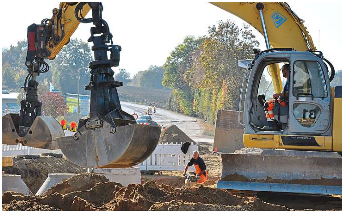
Weiter geht's: Nachdem der Straßenbau an der Westtangente (im Hintergrund) weitgehend abgeschlossen ist, wird jetzt der neue Kreisverkehr bei Heißmanning in Angriff genommen. Damit werden die Straße Richtung Weingarten und Pallertshausen sowie das neue Wohngebiet Weingartenfeld an die Umgehungsstraße angebunden. Foto: Straßer
